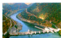
le barrage dam
